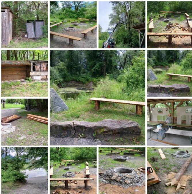
Notwendige Renovierung der Freiluftklasse
